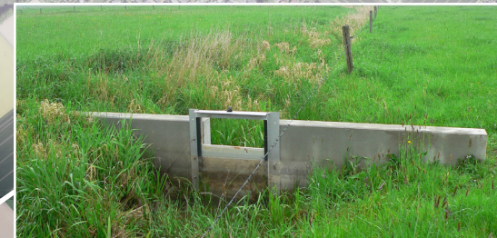
Mit mehreren verstellbaren Stauwehren wird ein Entwässerungsgraben aufgestaut und so wieder mehr Wasser länger in der Fläche gehalten
